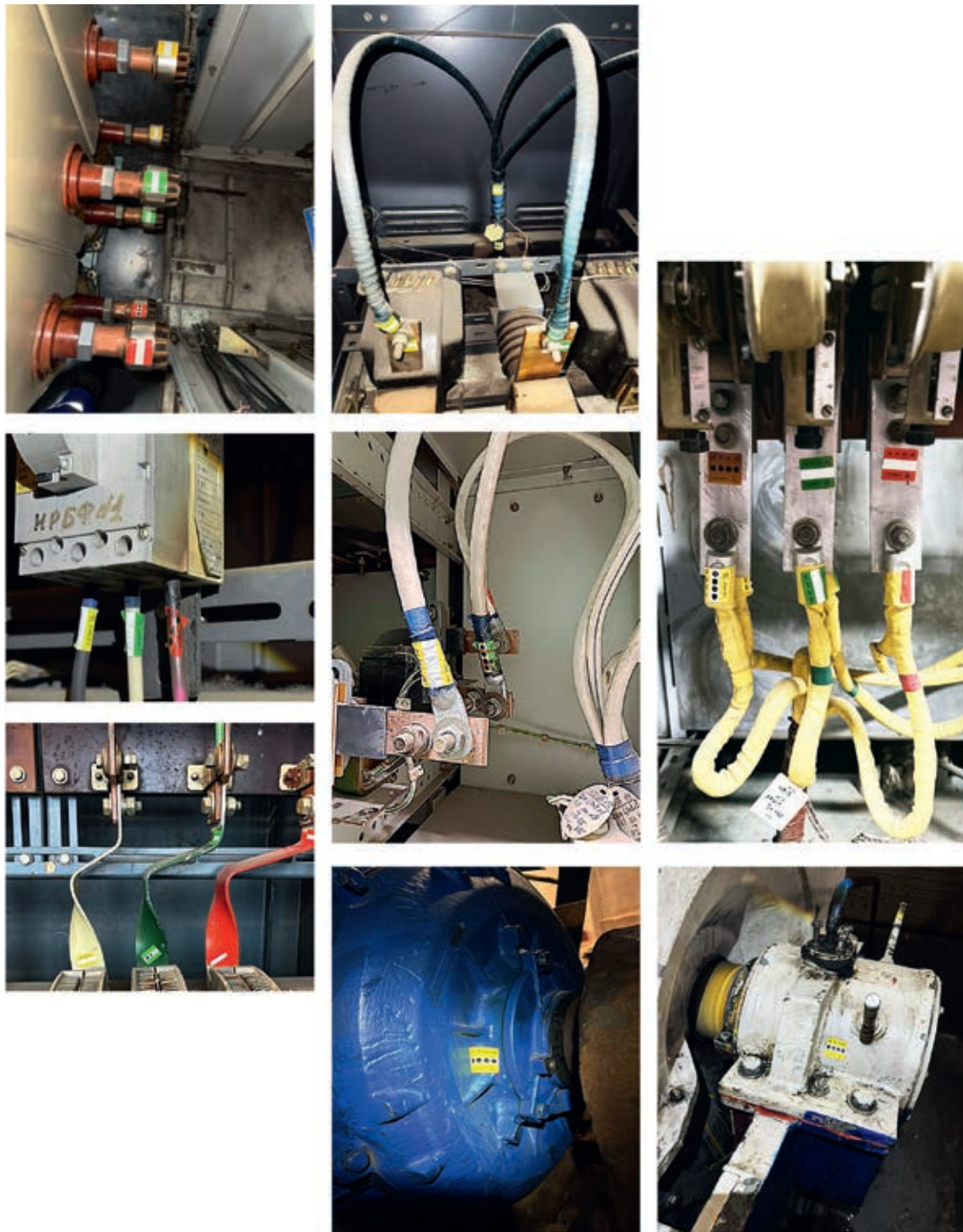
Рис. 6. Примеры выявленных дефектов с помощью термоиндикаторов на различных узлах оборудования
