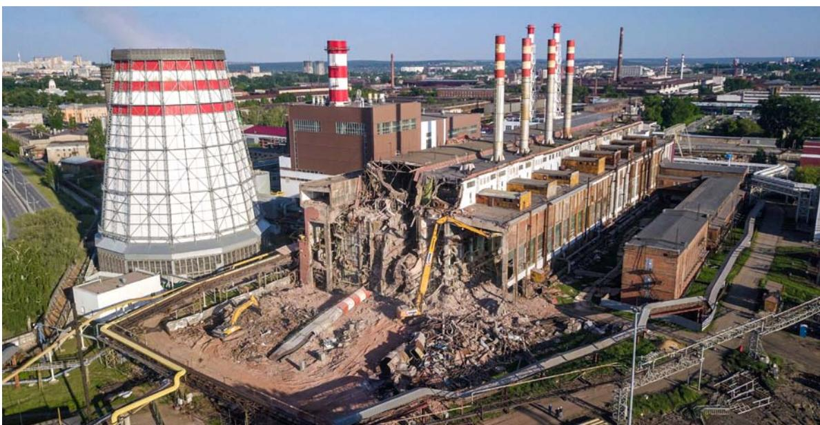
**Механизированный демонтаж экскаватором версии Demolition (в центре), сортировка строительного мусора (слева)**
