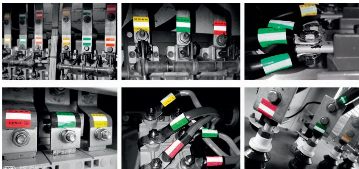
Рис. 2. Примеры установленных термоиндикаторов в ЗРУ
