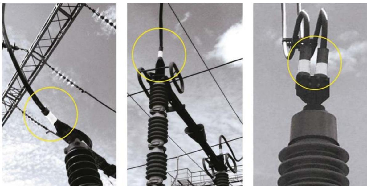
Рис. 3. Примеры установленных термоиндикаторов на ОРУ
