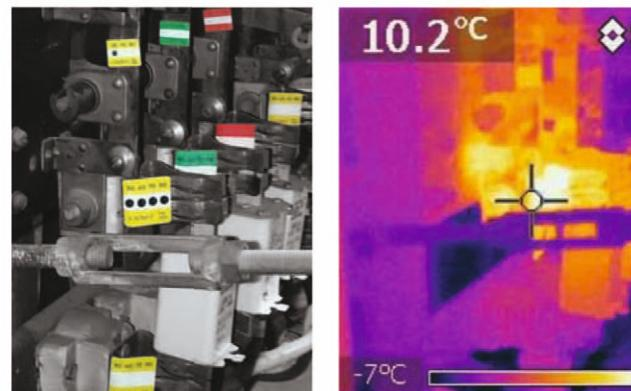
Рис. 6. Примеры срабатывания термоиндикаторов при наличии дефекта
