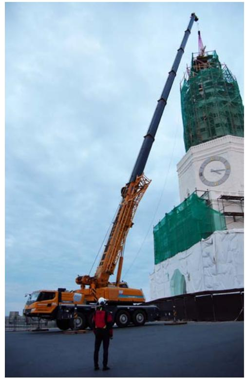
Демонтировав латунное покрытие звезды, измерили и оцифровали все детали, после чего выкроили их уже из нержавеющей стали. Кстати, звезда таким образом стала тяжелее – ее вес составил около 800 кг. Снятие и установка звезды было произведено специалистами и техникой компании «СОПиГ» – краном XCMG XCA 100\_S.
