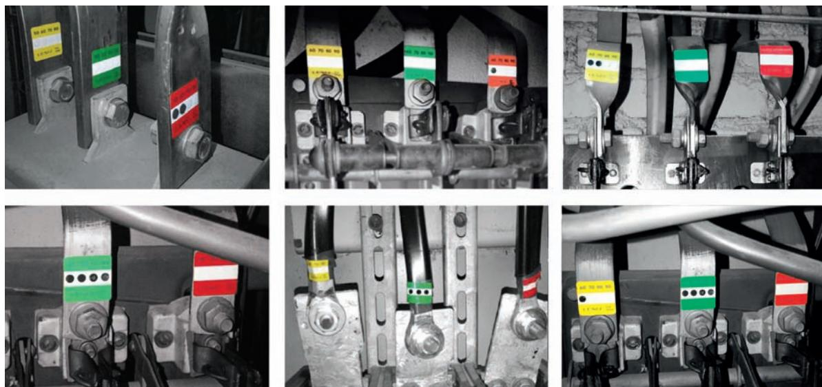
Рис. 4. Примеры срабатывания термоиндикаторов
