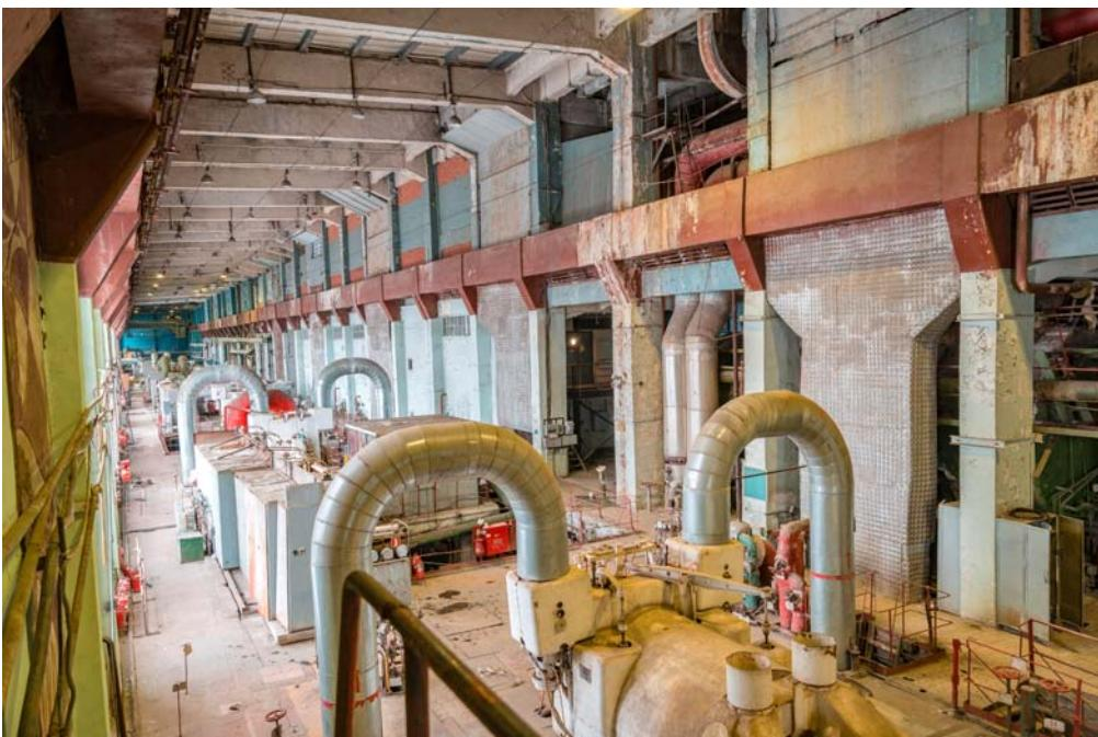
Здание главного корпуса из железобетонного несущего каркаса (колонны, балки), стены заполнены кирпичной кладкой
