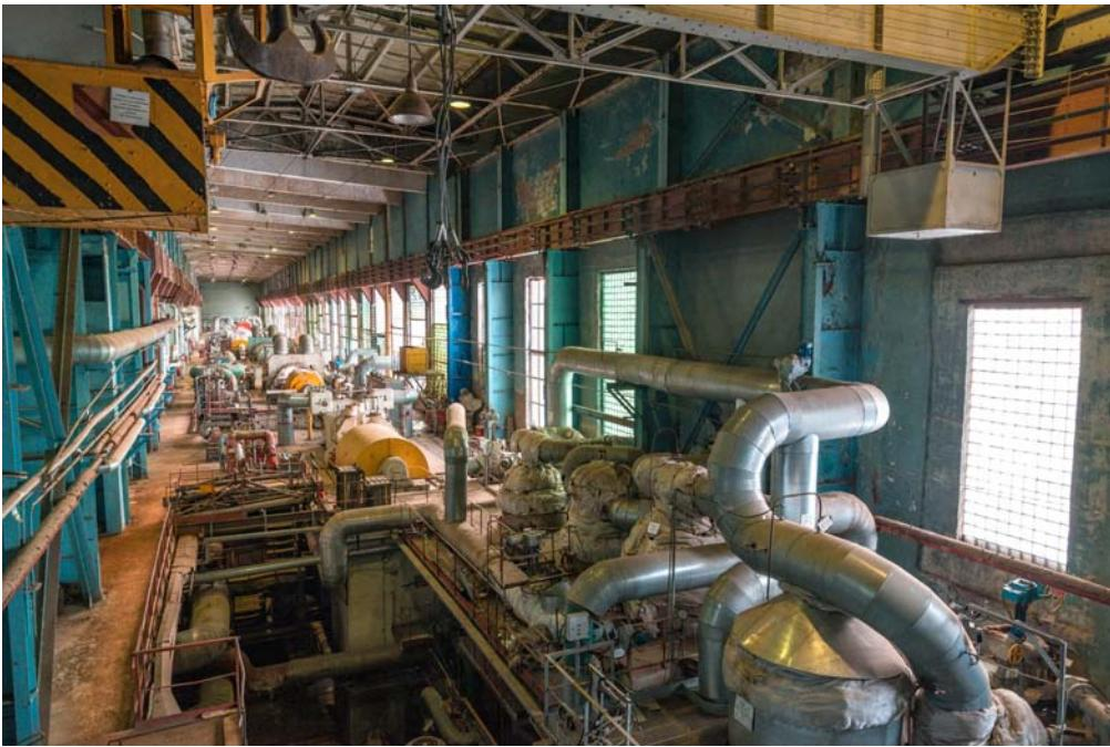
Внутри главного корпуса: три водогрейных котла, шесть энергетических котлов, семь турбогенераторов
