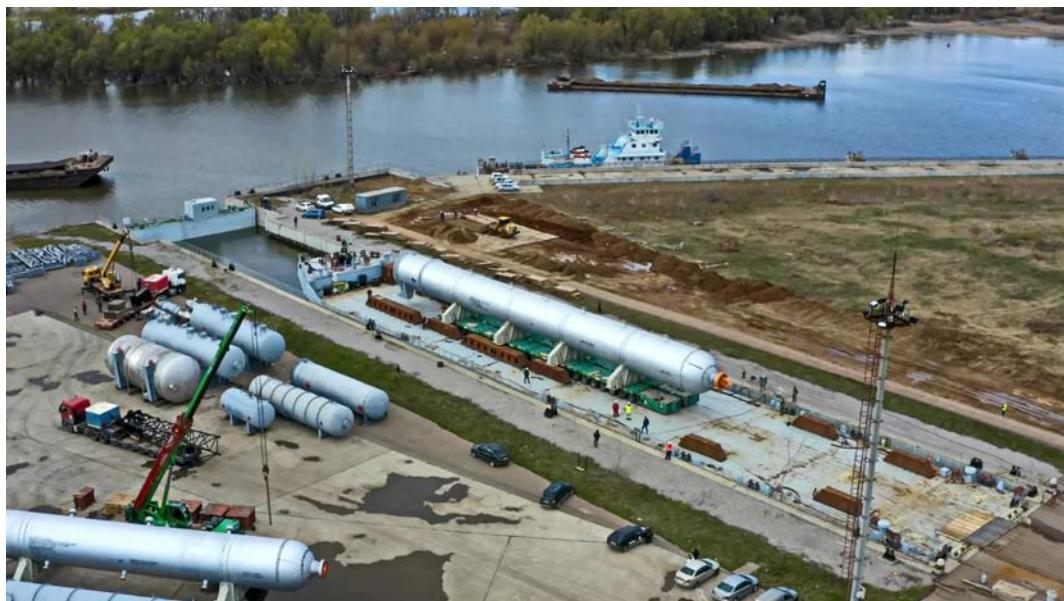
Далее, на этом же специализированном транспортном средстве была осуществлена транспортировка реакторов от причала до строительной площадки завода «ТАНЕКО». Длина маршрута составила 18 км по дорогам общего пользования г. Нижнекамска.
