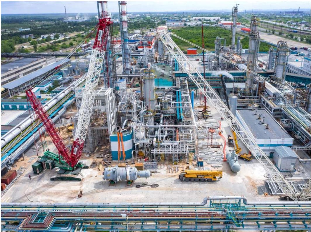
После успешной доставки аппарата на территорию завода «СИБУР-Нефтехим» специалисты компании «СОПиГ» осуществили перекидку оборудования через два действующих продуктопровода, а затем и установку реактора в проектное положение. Данные работы выполнены с помощью крана LIEBHERR LR 1750 грузоподъемностью 750 тонн. ■
