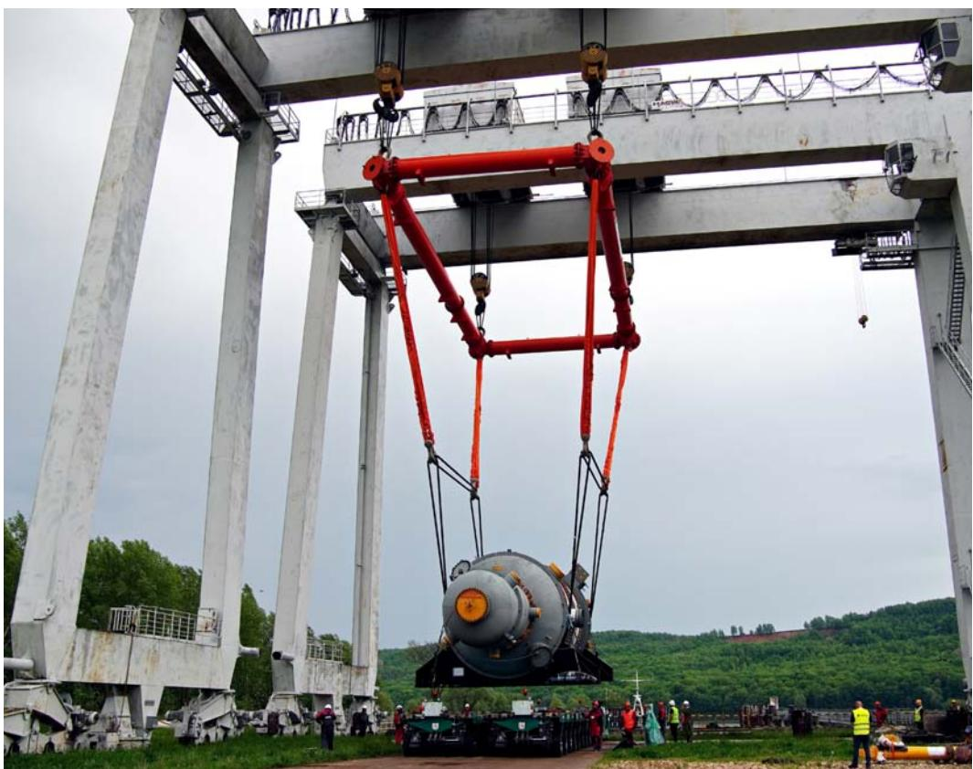
Для перевозки тяжеловесного оборудования было использовано четыре шестиосных самоходных транспортеров с двумя двигателями РРУ.
