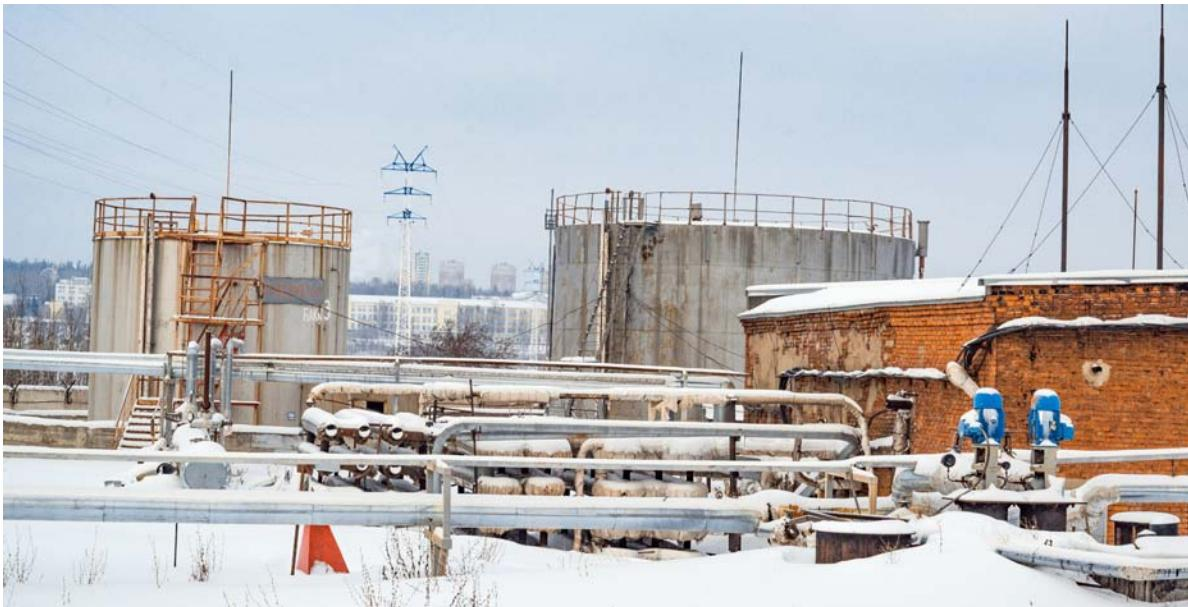
**Топливное хозяйство на мазуте выведено из эксплуатации: кирпичное здание насосной (высота 4 м, длина 20 м, ширина 19 м), три резервуара хранения мазута объемом 1000 куб. м**
