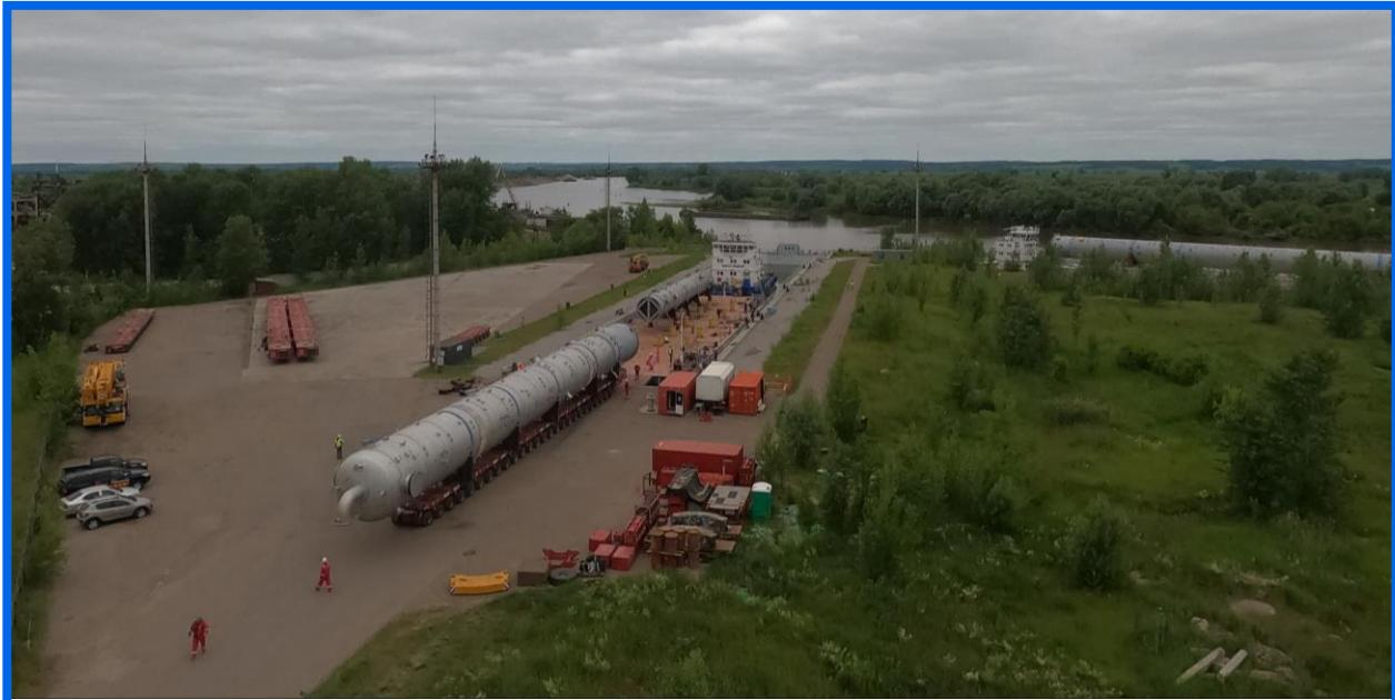
Наземная часть маршрута до строительной площадки, представляла собой 21-километровый путь с множеством препятствий. На время перевозки тяжеловесных и негабаритных грузов необходимо было демонтировать и улучшить несколько крутых поворотов, эстакады, ограждения и прочие надземные препятствия, такие как высоковольтные линии электропередач, дорожные знаки, светофоры.
