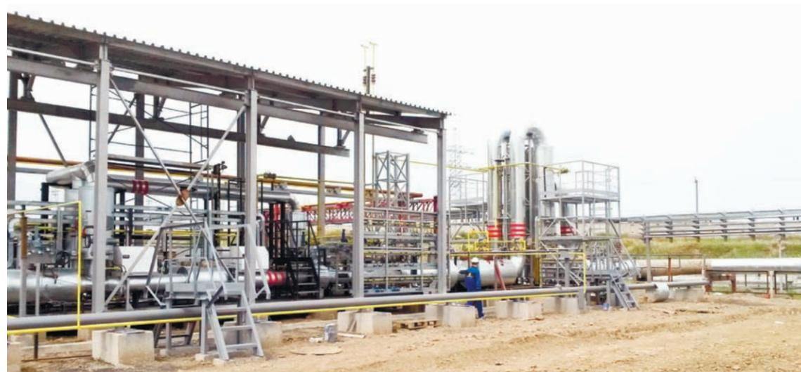
Система коммерческого учёта нефти в резервуарном парке объекта «Береговые сооружения для приёма нефти, поступающей с морских месторождений Северного Каспия»
