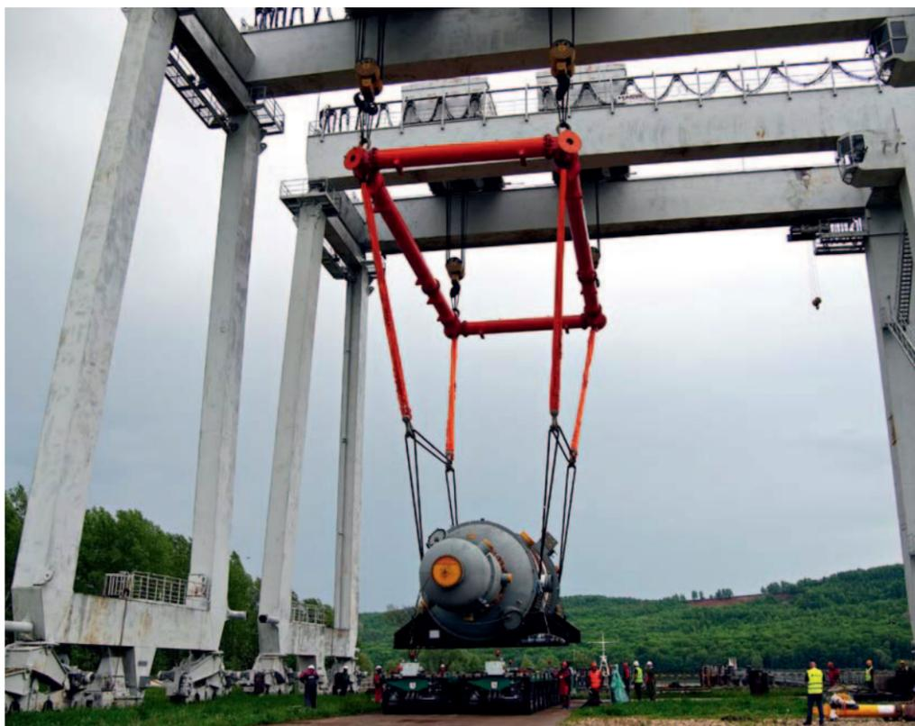
Для перевозки тяжеловесного оборудования было использовано четыре шестиосных самоходных транспортеров с двумя двигателями PPU.
