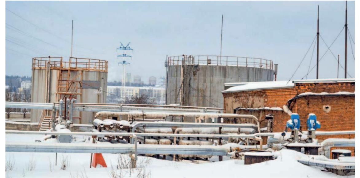
Топливное хозяйство на мазуте выведено из эксплуатации: кирпичное здание насосной (высота 4 м, длина 20 м, ширина 19 м), три резервуара хранения мазута объемом 1000 куб. м
