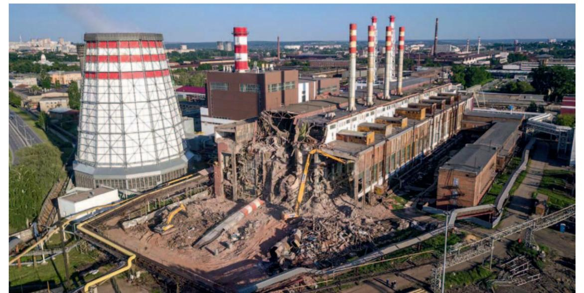
Механизированный демонтаж экскаватором версии Demolition (в центре), сортировка строительного мусора (слева)
