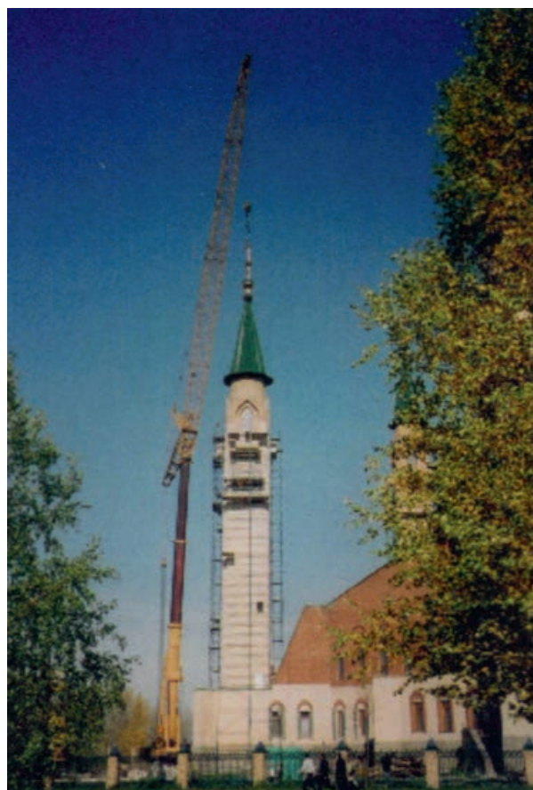
Подъём и установка минаретов были произведены компанией «СОПиГ»
