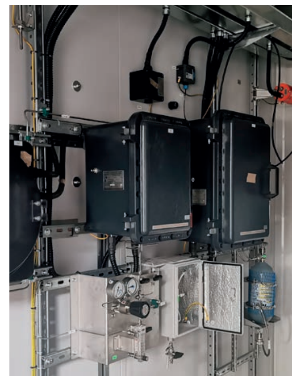
Варианты размещения хроматографов в шкафу и блок-боксе взрывозащищенном
