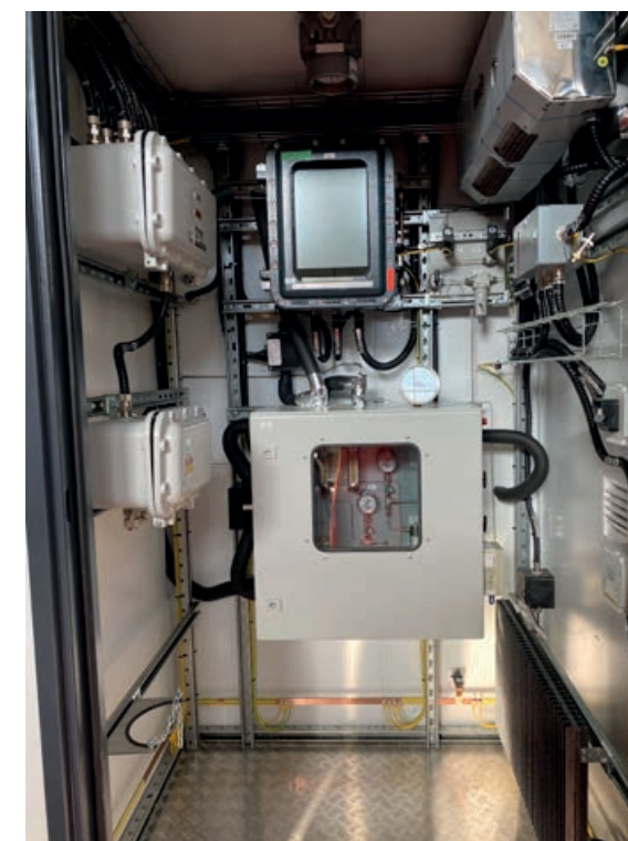
Варианты размещения хроматографов в шкафу и блок-боксе взрывозащищенном
