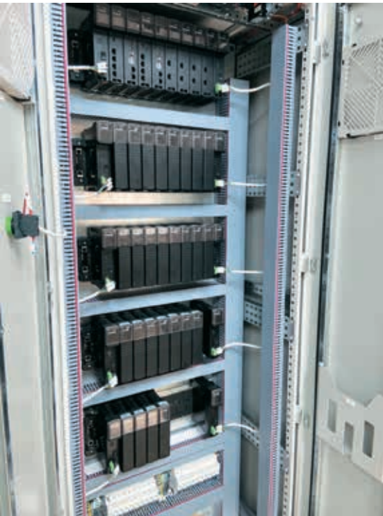
АСУТП на базе ПЛК и SCADA
