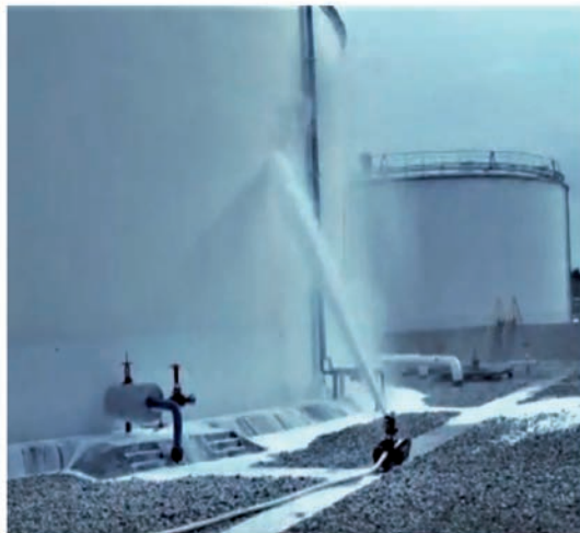
Рис. 8. Применение МРУП для подачи компактных и распыленных струй воды и компрессионной пены:
