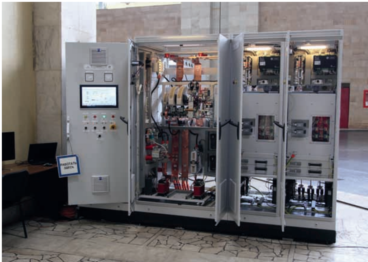
Рис. 2. Структура условного обозначения СТС-М-2П-400-1450 УХЛ4 расшифровывается следующим образом: СТС – система тиристорная статическая; М – Метран; 2 – двухканальная; П – принудительное охлаждение; 400 – номинальное выходное напряжение СТС; 1450 – номинальный выходной ток СТС; УХЛ – климатическое исполнение; 4 – категория размещения
