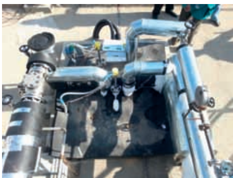
Насосы компании HERMETIC для перекачки сжиженного этилена ( -104^{\circ}\text{C} )
