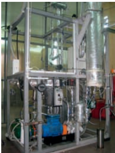
Фото 1. Универсальная пилотная установка каталитического гидрирования и алкирирования углеводородного сырья
