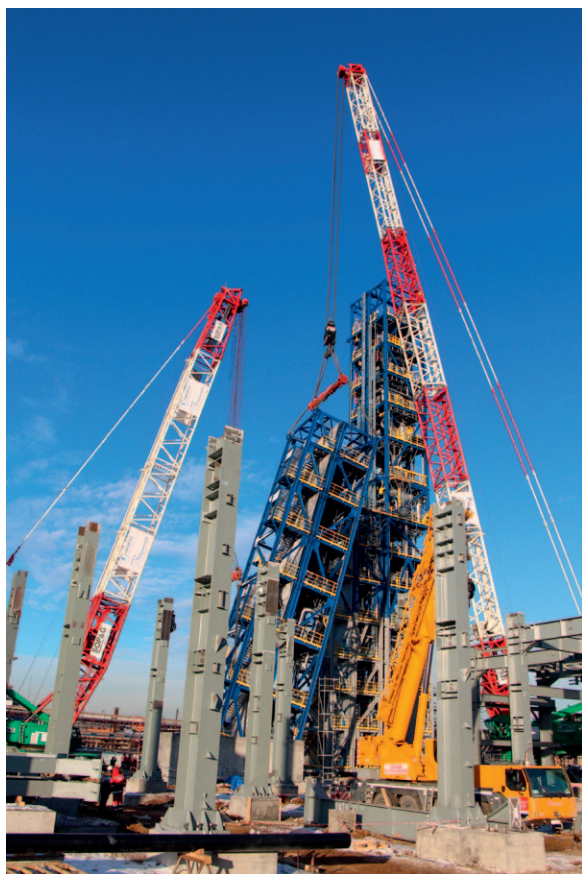
Монтаж модулей НРК
