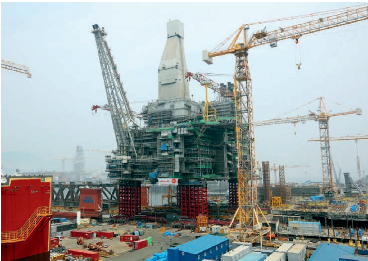
Рис. 2. Мировой рекорд: подъем ВС при помощи MJS5200, 42'700 т, проект Аркутун-Даги, Корея, 2013 г.
