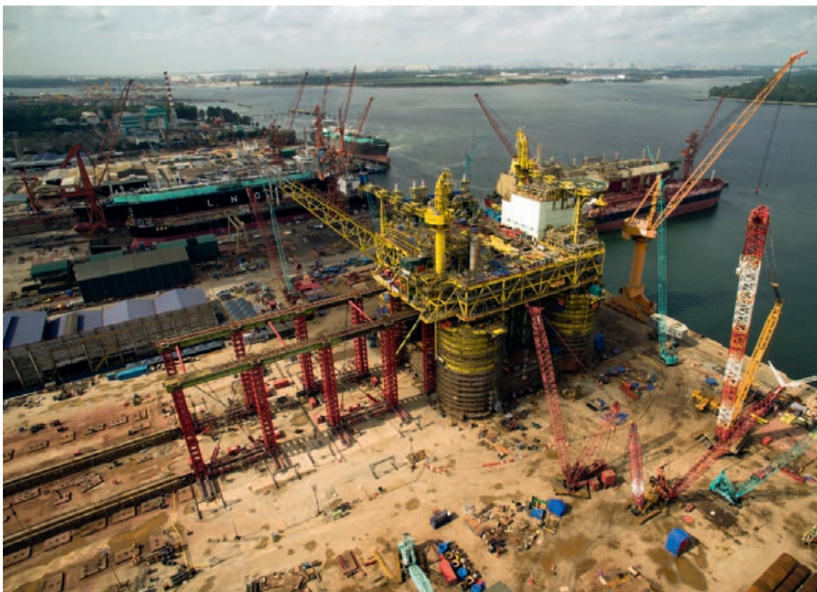
Рис. 8. Стыковка ВС на высоте 40 м, проект Маликай, Малайзия, 2015 г.
