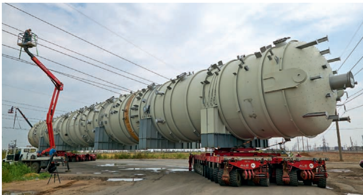
Рис. 11. Маневрирование при транспортировке колонны с подъемом ЛЭП, 501 т, Волгоград, 2014 г.
