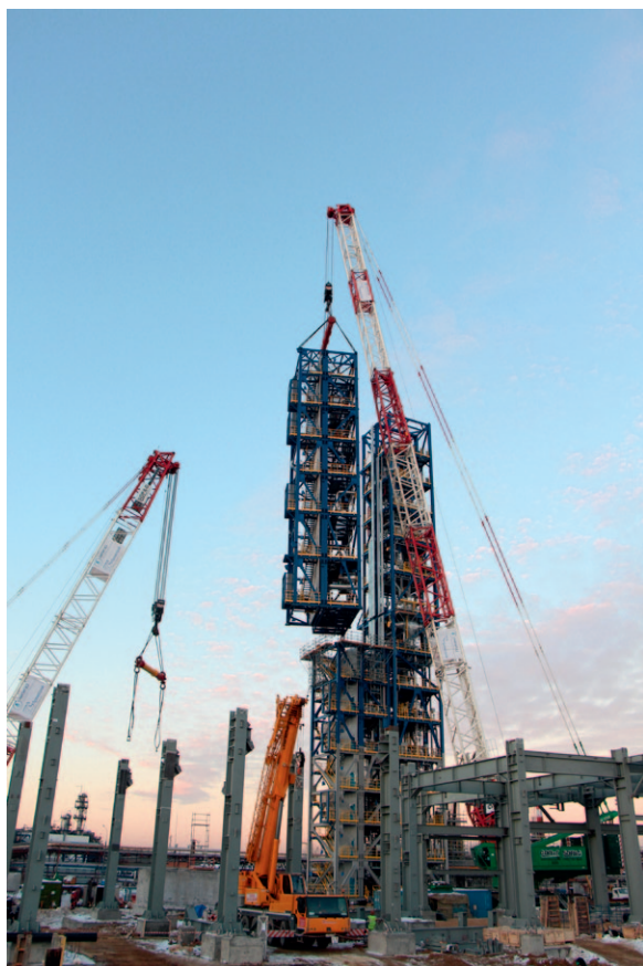
Монтаж модулей НРК
