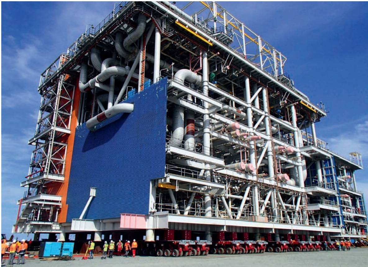
Рис. 14. Транспортировка модулей для проекта Ямал СПГ, порт Зебрюгге, 2016 г.
