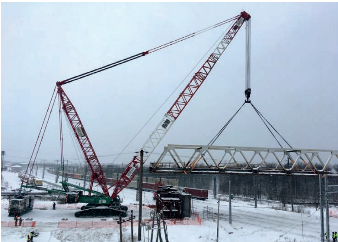
Демонтаж фермы пролетного строения автомобильного моста над ж/д путями, кран LR 1750, Ленинградская область, пос. Мга
