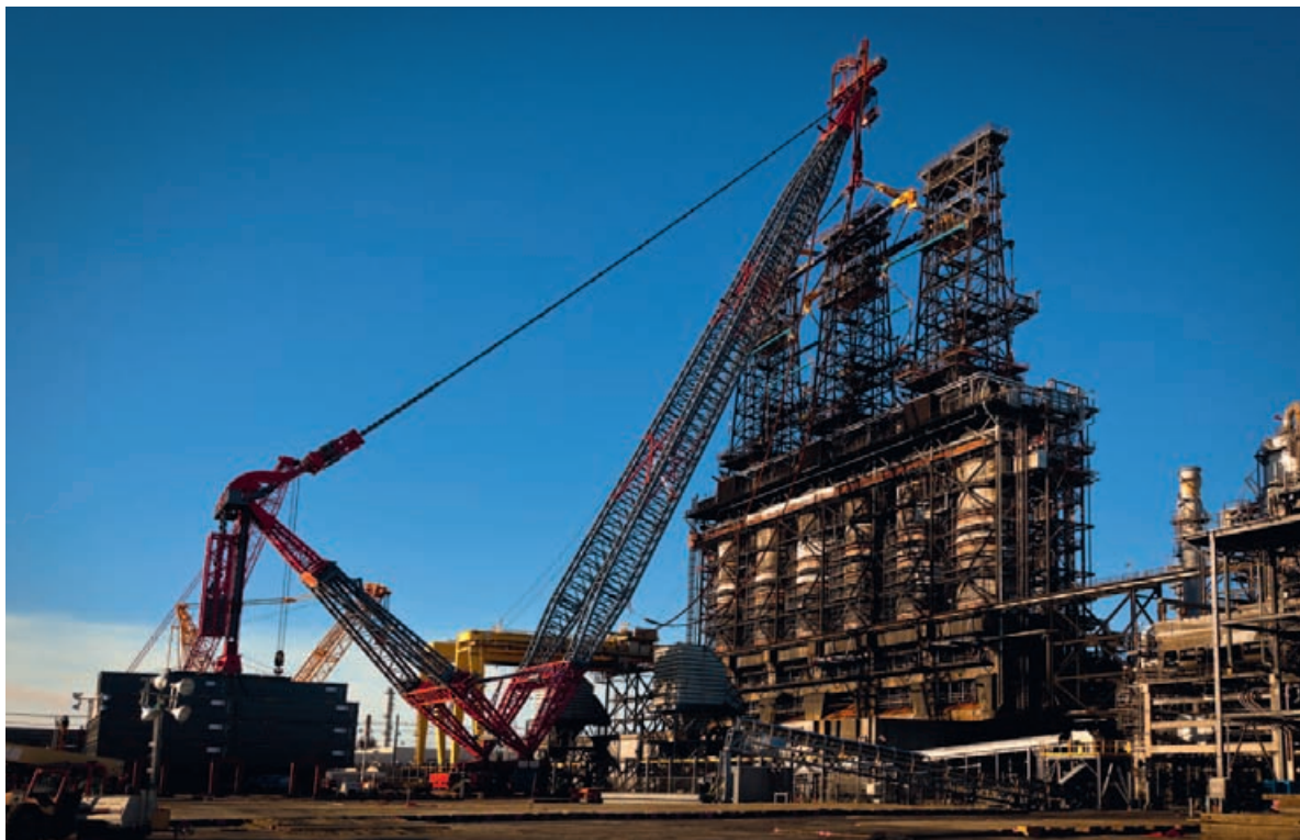
Рис. 16. Подъем этажерки массой 1400 т при помощи крана AL.SK190, проект Valero, США, 2011 г.
