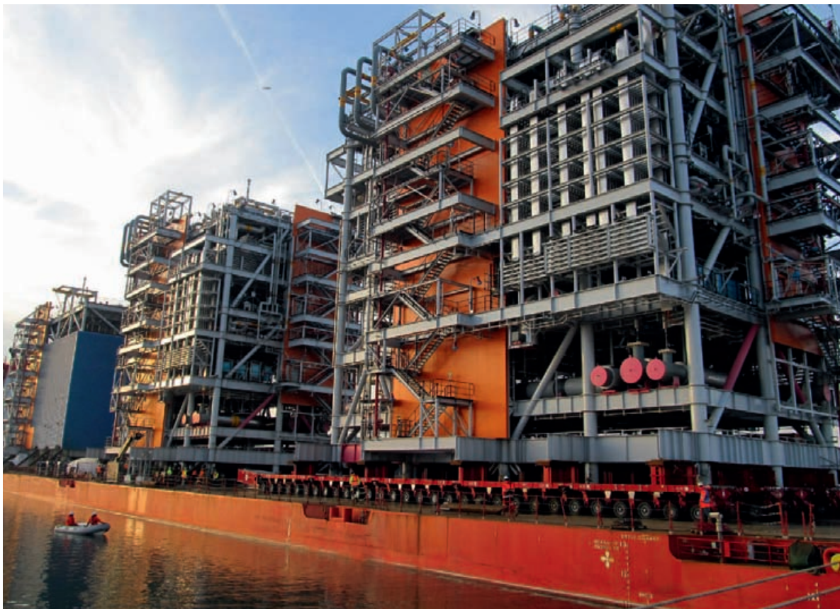
Рис. 15. Транспортировка модулей для проекта Ямал СПГ, порт Зебрюгге, 2016 г.
