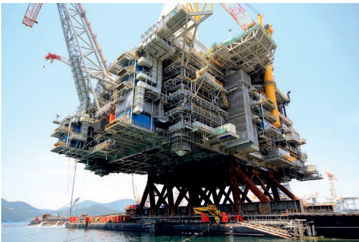
Рис. 3. Мировой рекорд: продвижка ВС с ТМР, 47'830 т, проект Аркутун-Даги, Корея, 2013 г.
