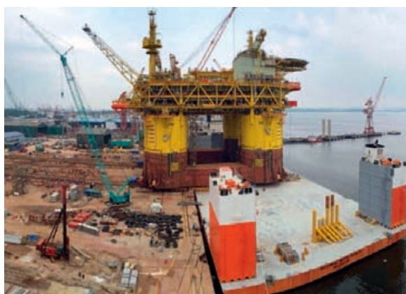
Рис. 6. Надвигка собранной платформы, 27'500 т, проект Маликай, Малайзия, 2015 г.
