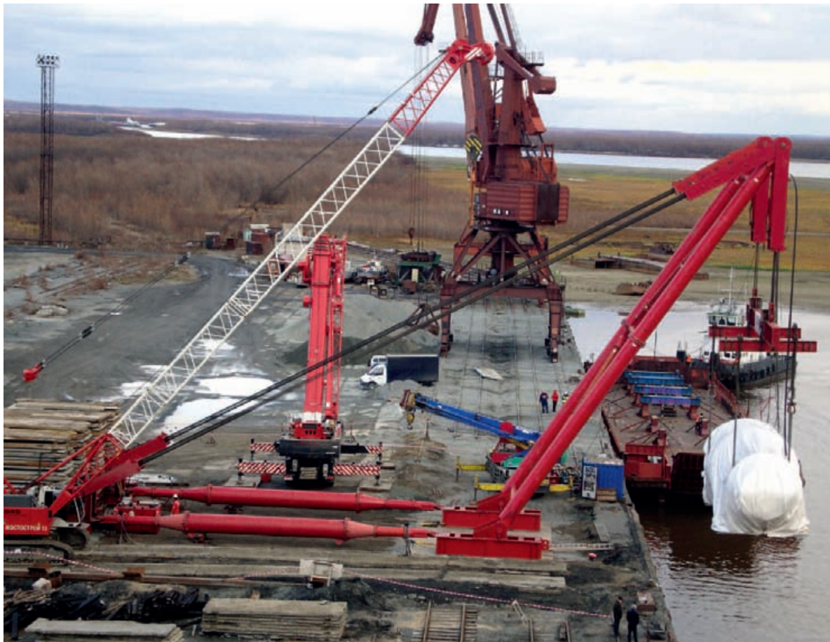
Рис. 9. Перегрузка КТГ при помощи рычажно-домкратного подъемного механизма ALE, Лабитнанги, 2011 г.
