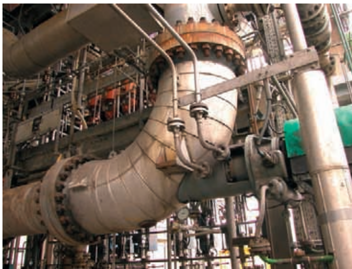
Рис. 2. Составная часть реактора с приводом через карданный вал. При этом электродвигатель жестко закреплен на фундаментной плите
