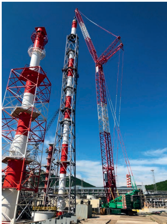
Монтаж оборудования, кран LR 1350/1, г. Туапсе, ООО РН-Туапсинский НПЗ
