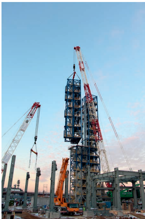
Монтаж модулей НРК
