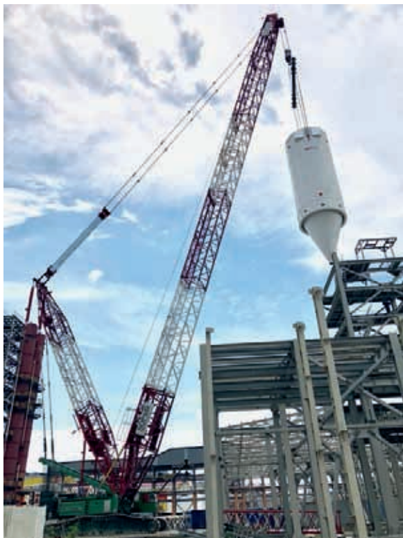
Монтаж оборудования, кран LR 1350/1, г. Туапсе, ООО РН-Туапсинский НПЗ
