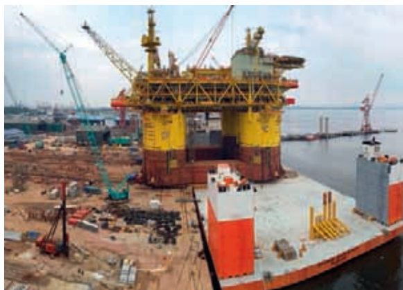
Рис. 6. Надвигка собранной платформы, 27'500 т, проект Маликай, Малайзия, 2015 г.
