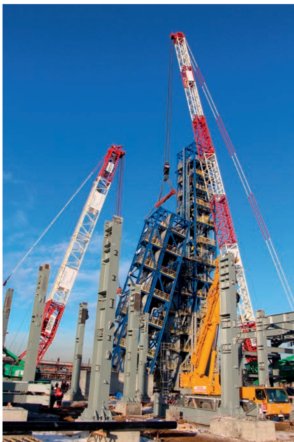
Монтаж модулей НРК
