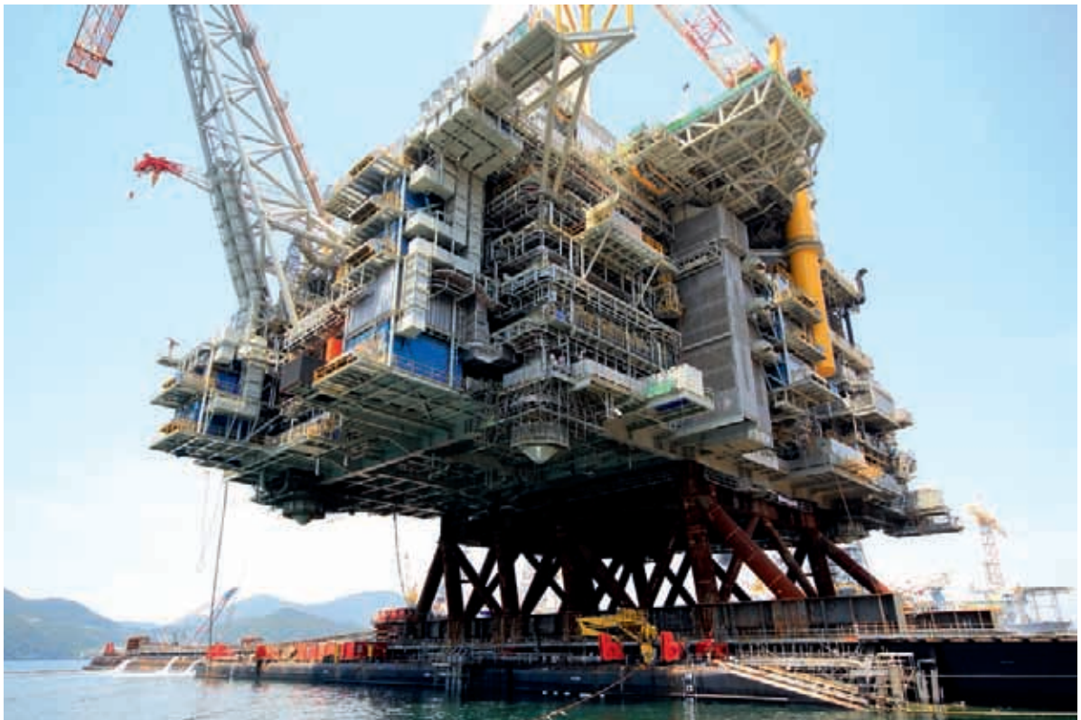
Рис. 3. Мировой рекорд: продвижка ВС с TMR, 47'830 т, проект Аркутун-Даги, Корея, 2013 г.
