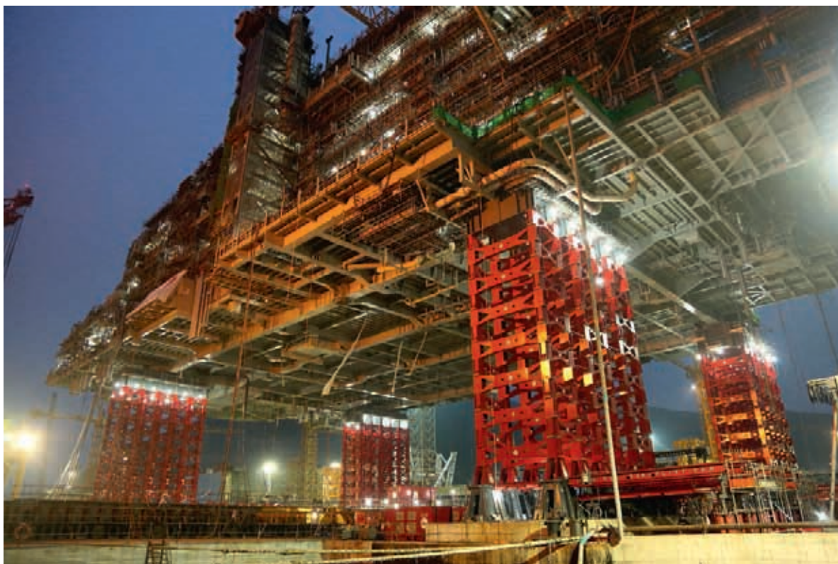
Рис. 1. Мировой рекорд: подъем ВС при помощи MJS5200, 42'700 т, проект Аркутун-Даги, Корея, 2013 г.
