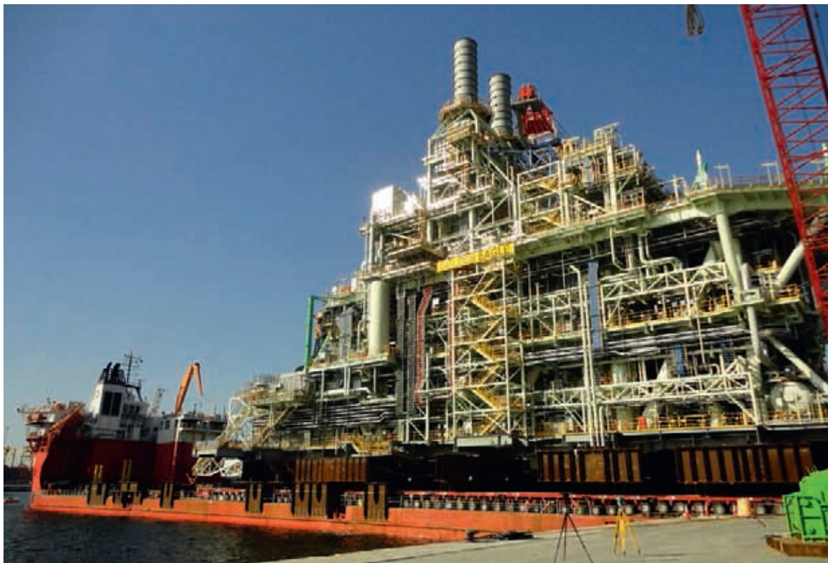
Рис. 4. Рекорд Гиннеса: транспортировка ВС массой 13'200 т, проект GEAD, ОАЭ, 2014 г.
