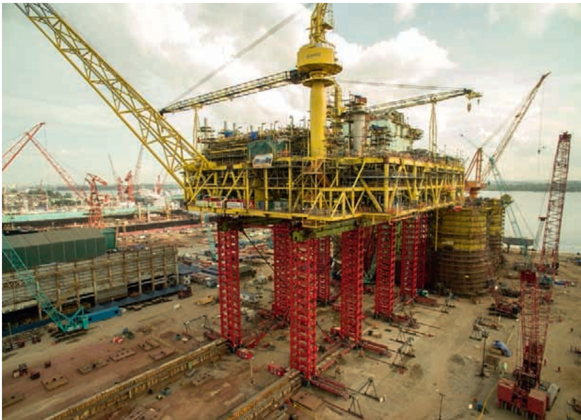
Рис. 7. Надвигка ВС на высоте 40 м, проект Маликай, Малайзия, 2015 г.
