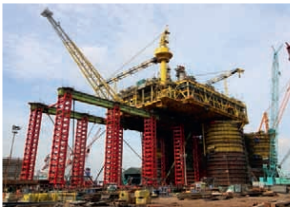
Рис. 5. Надвигка ВС массой 13'800 т на высоте 40 м, проект Маликай, Малайзия, 2015 г.
